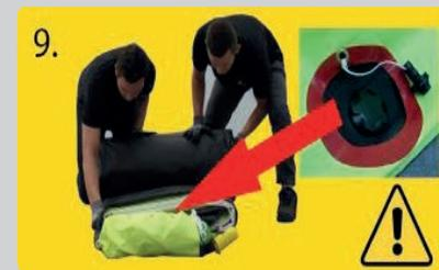
Gepürfte und gefüllte Druckluftflasche in der Flaschenhalterung positionieren.
