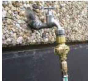
Riduttore nipplo/baionetta con tubo flessibile di alimentazione dell'aria
