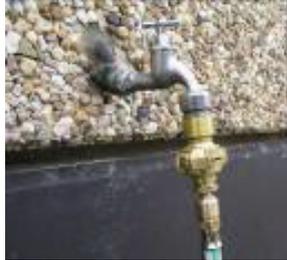
Élément de transition nipple/baïo avec flexible d'alimentation en air
